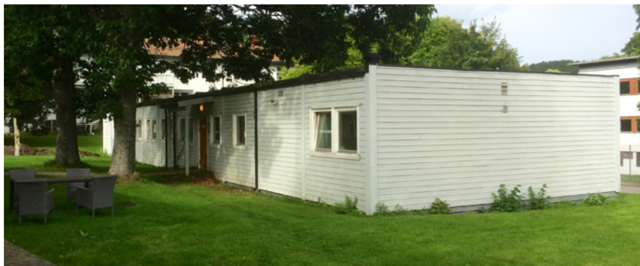
Brakkebygget med overlegenes soverom
